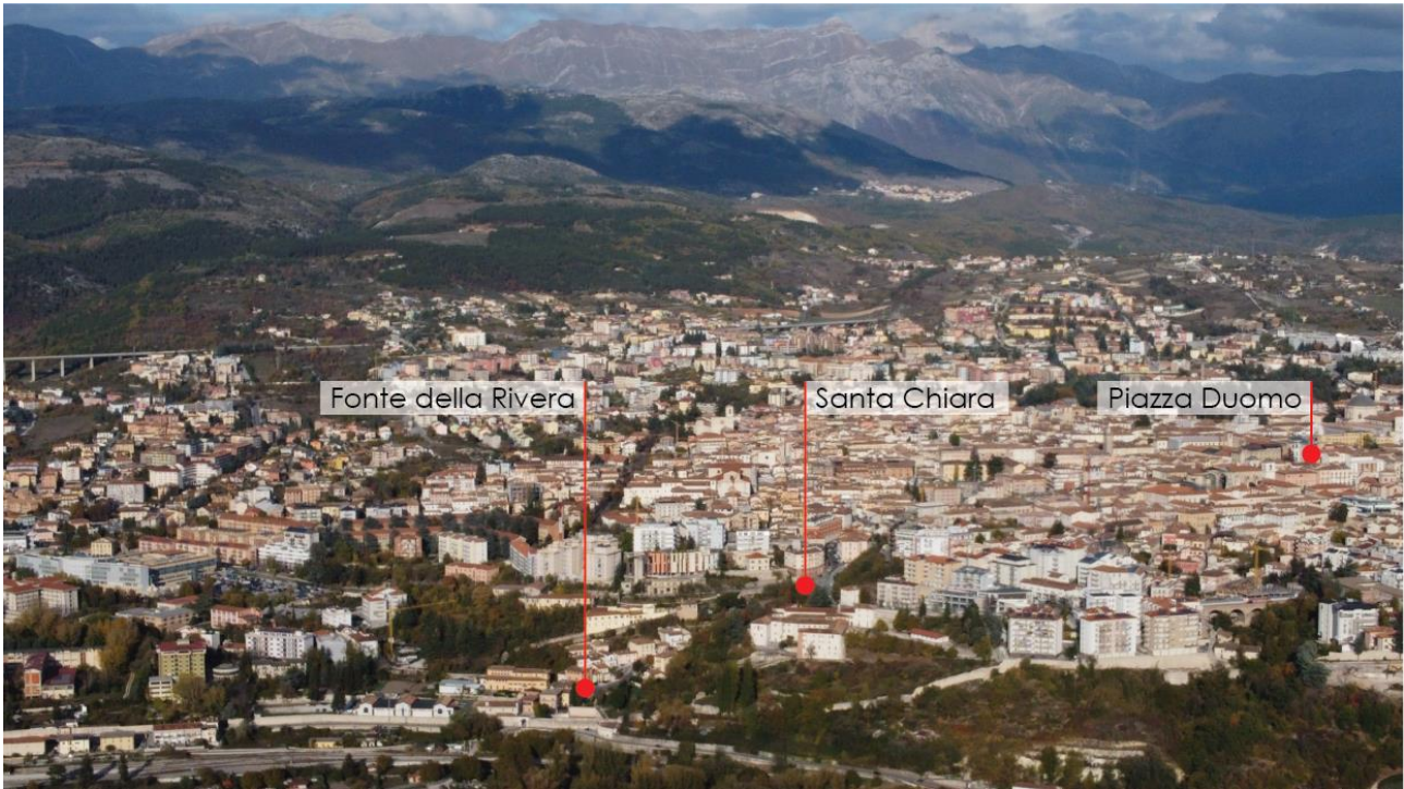
Fig.1.1.2 – Vista meridionale della città dalla collina di Monte Luco. La fonte della Rivera si trova più in basso del convento di Santa Chiara, che domina il fianco destro del compluvio che risale fino a piazza Duomo, cento metri più in alto della fontana. Ben visibile anche il circuito delle mura che poco dopo Porta Rivera, sale rapidamente fino alla Porta Roiana.
