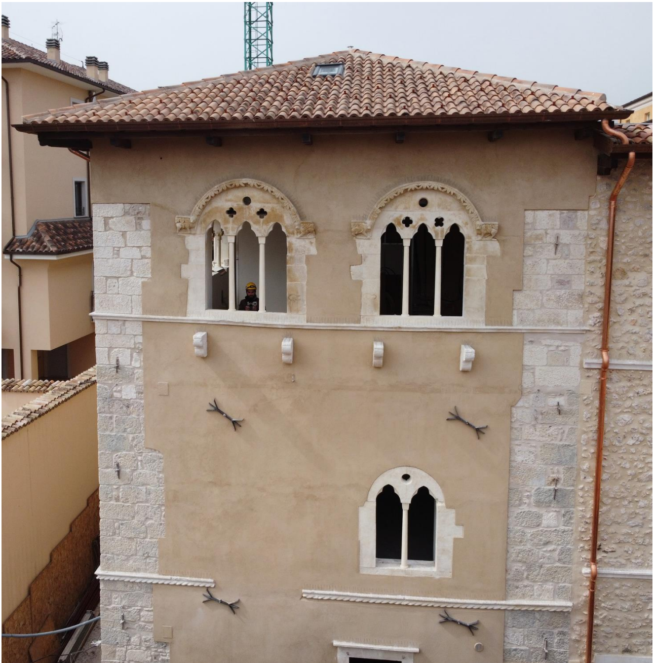
Fig.3.1.4.5 – Prospetto in Via Romanelli. Oltre alle due cornici marcapiano ed alla bifora al primo piano, abbiamo l'unico riscontro di trifore nell'ambito dell'architettura civile nel centro storico. Il disegno di quest'ultime è molto simile a quello della bifora in Via Collepietro (Fig.3.1.4.4).
