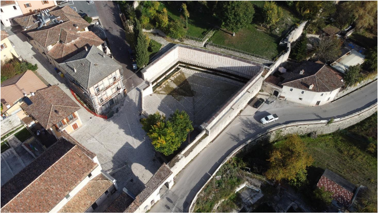
Fig.1.1.3 – Vista aerea della Fonte della Rivera, in basso a sinistra la chiesa di San Vito di Tornimparte, la porta urbana, le mura a cui si appoggia il prospetto meridionale della fontana; sulla sinistra le prime case del “Borgo Rivera”.
