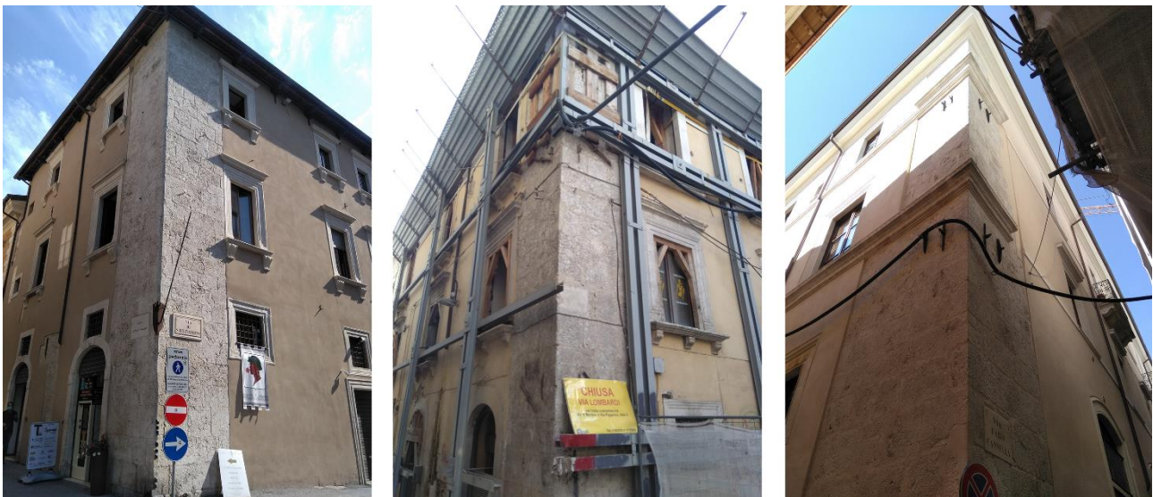
Fig.3.1.6.1 – Esempi di cantonali in grandi blocchi.
