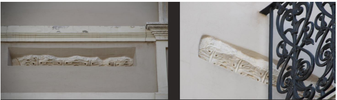
Fig.3.1.4.3 – Piazzetta Alfieri, lacerti di cornice a foglie d'acanto rinvenuti durante i lavori di restauro conseguenti il terremoto del 2009 e lasciati a vista.
