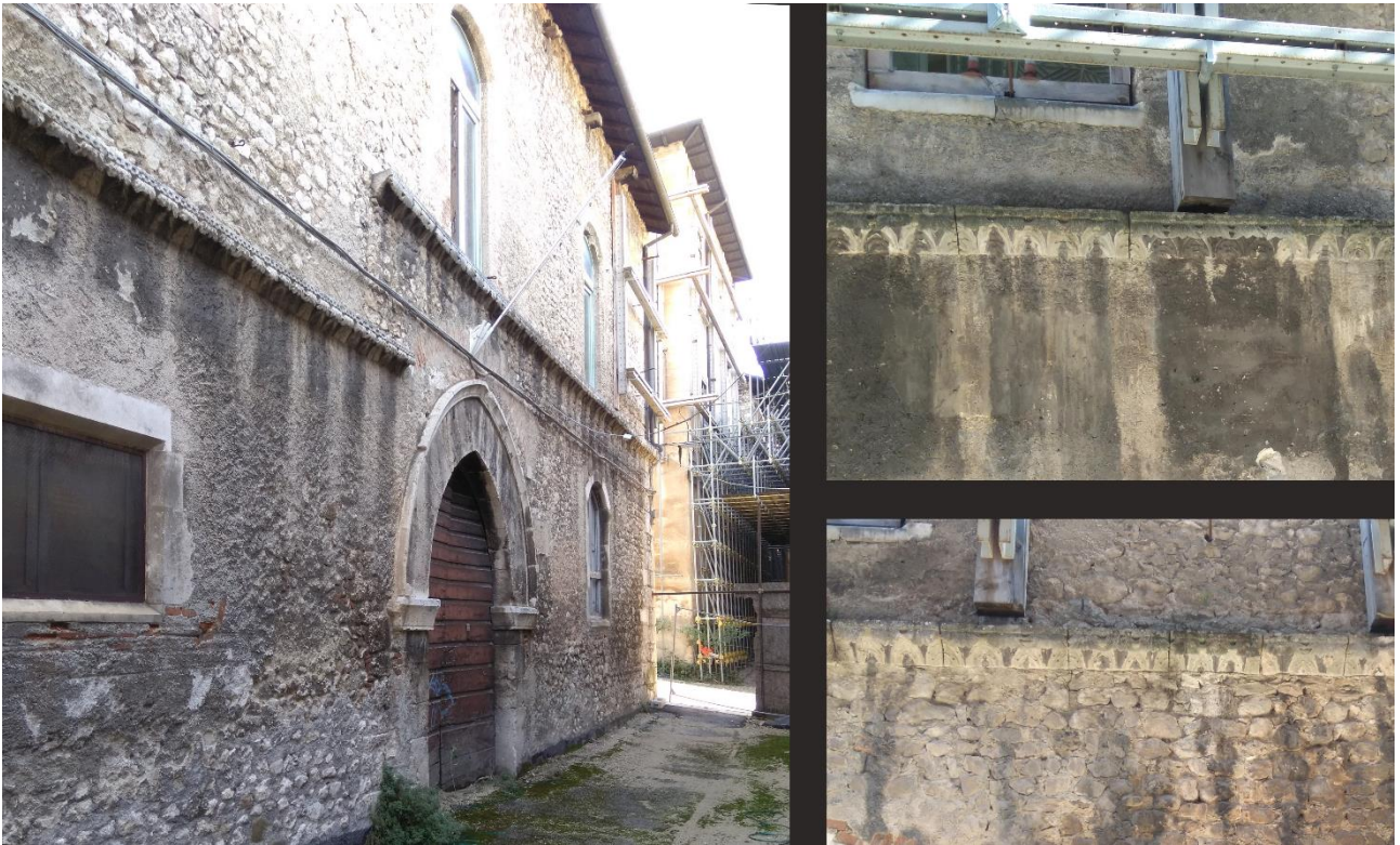
Fig.3.1.4.2 – Via Cesura, le cornici a foglie d'acanto corrono per quasi tutta la lunghezza del prospetto, sebbene a quote diverse, per proseguire anche oltre l'angolo nel risvolto su Via Sassa.
