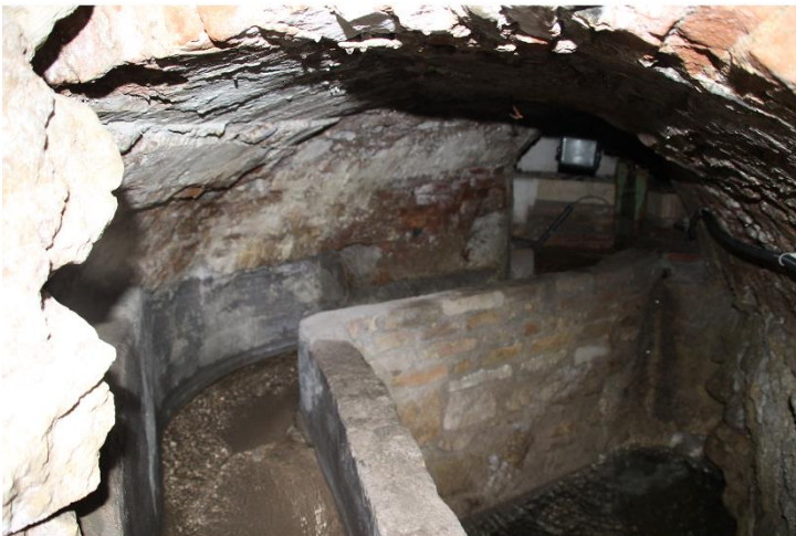
Fig.1.1.1.1 – Le opere di presa ed i condotti di distribuzione nella galleria dietro il prospetto Nord ed il Prospetto Est della Fonte della Rivera. Dall'alto a sinistra in senso orario la sorgente 'S3', la sorgente 'S1', la sorgente 'S2', la vasca di raccolta all'angolo Nord-Est, il canale di adduzione parallelo al prospetto Nord.
