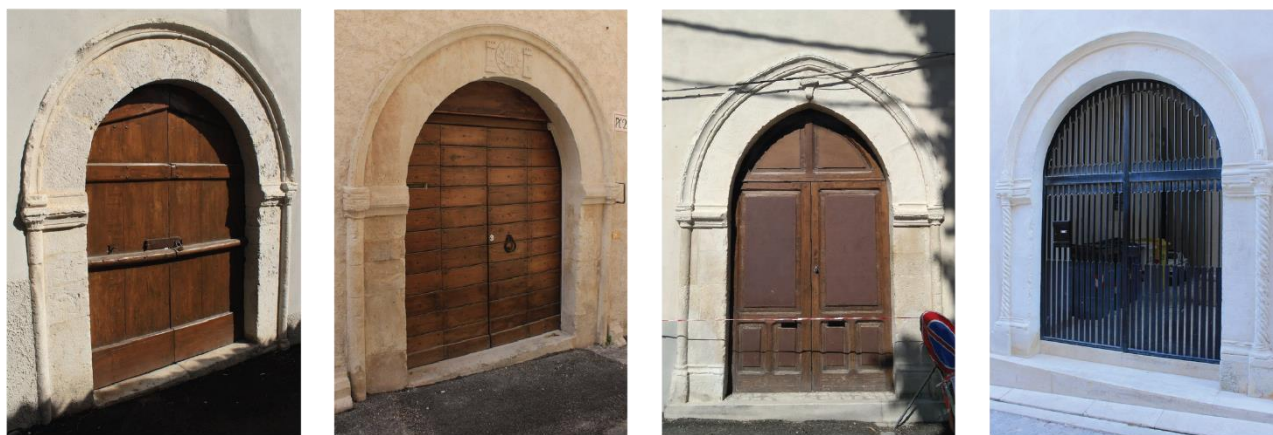
Fig.3.1.2.7 – Alcuni dei portali ‘PX_B’ (da sinistra) P2_709, P2_2027, P1_85, P2_107.
