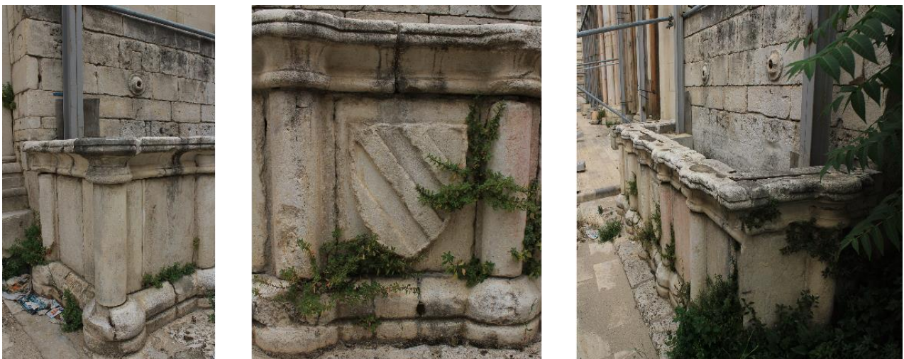
Fig.1.2.6.3– Dettagli della fontana di Santa Giusta (da sinistra a destra): l'angolo sinistro della fontana, con la colonnina cilindrica a scandire il parapetto, lo scudo con l'arma dell'Università di Bassano, il parapetto continuo, sebbene alquanto degradato.
