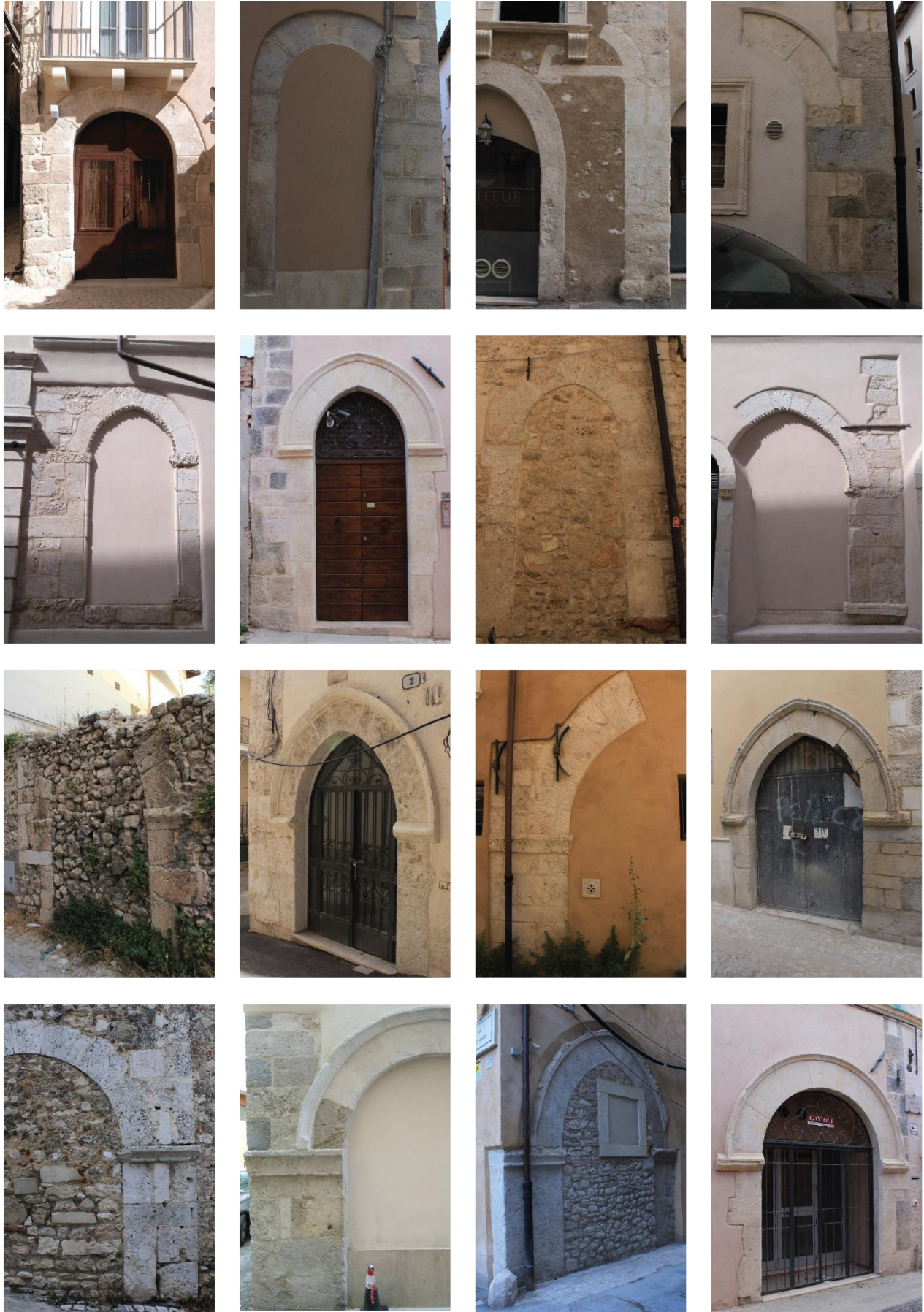
Fig.3.1.6.2 – Esempi di integrazione tra portale e cantonale..
