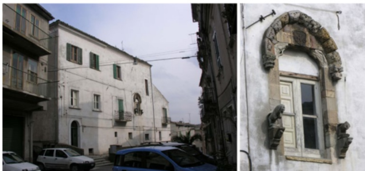
3: Dettaglio di palazzo De Marco, con vista sul fronte principale in corrispondenza di via Salita Castello, con dettaglio della finestra in stile gotico-pugliese ad arco acuto, con cornice decoramentale.
