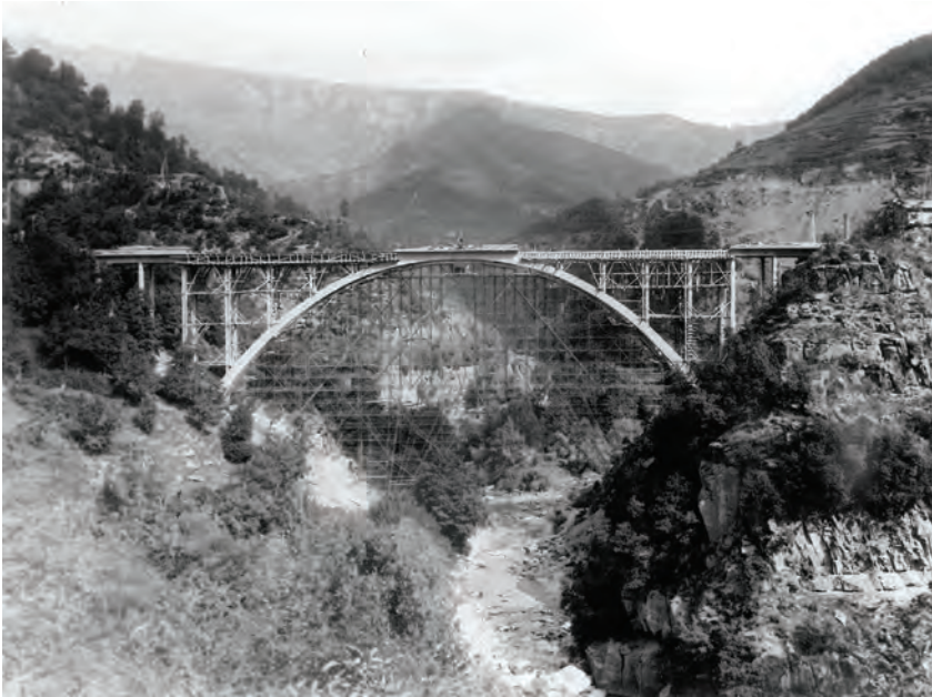
Figure 2.3.10 Bridge over the Vomano River, 1952–1953 photo during construction. Source: Uffici Amministrazione Provinciale di Teramo.
