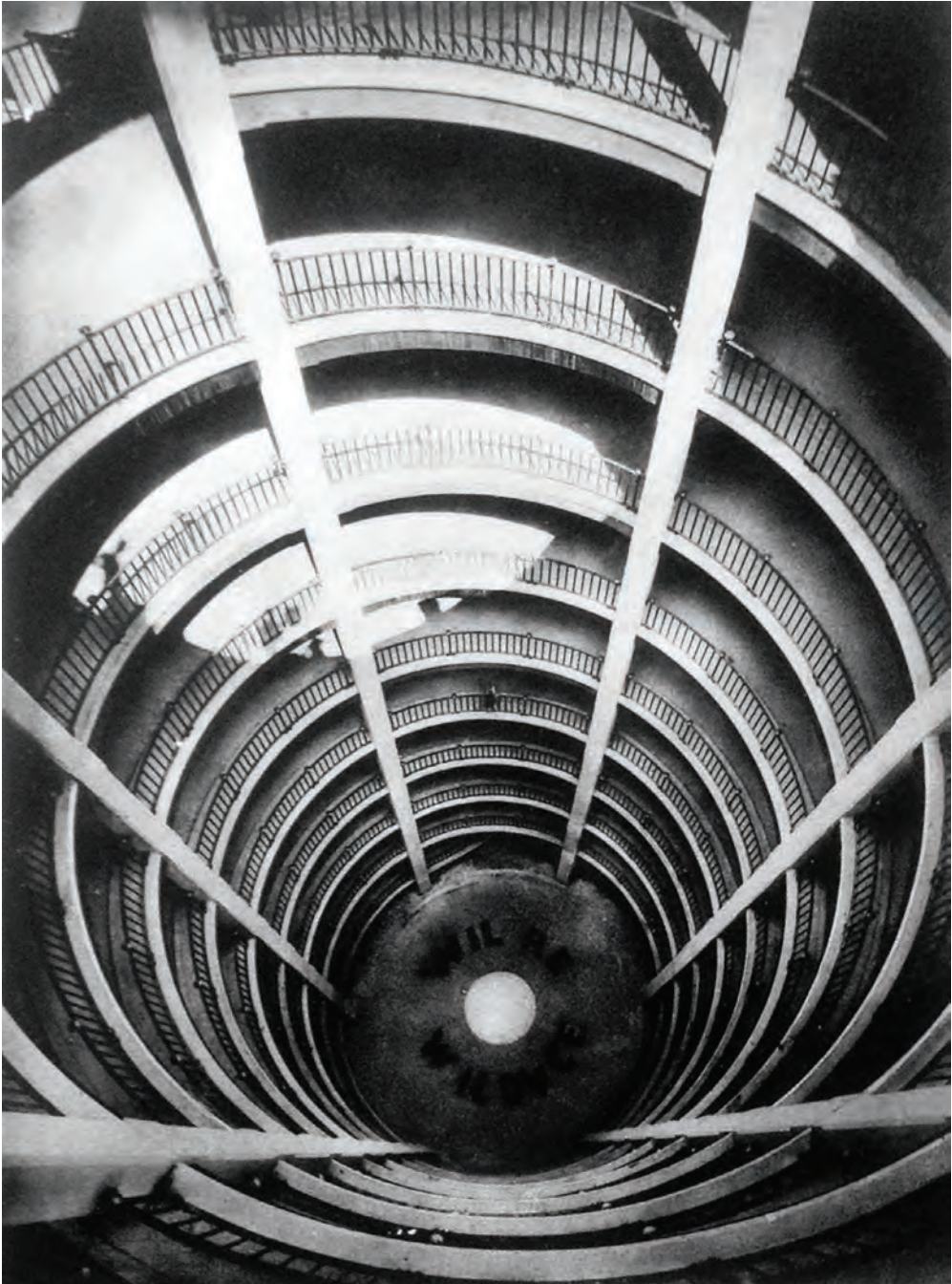
Figure 2.3.14 La Casa dell'Automobile in Piazza, Rome. The distribution ramp complete from the top.
