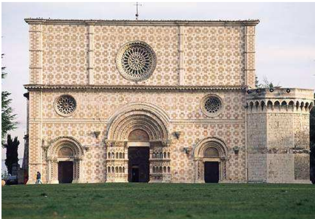
Figure 4. The Basilica di Santa Maria di Collemaggio
