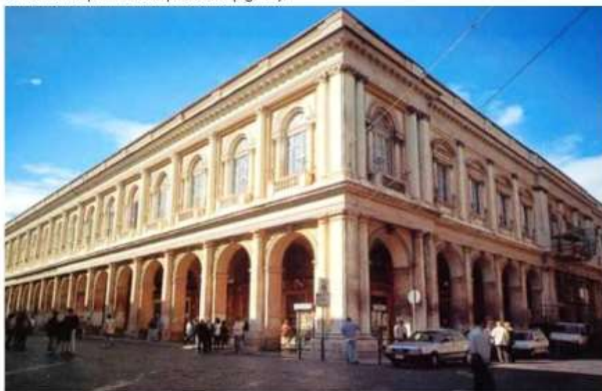
Figura 46, Intersezione dei Quattro Cantoni: Portici del Liceo e del Corso (fonte: centro.it)
