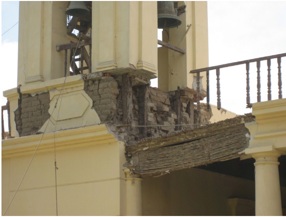
Figura 2. Formas arquitectónicas barrocas coloniales y técnicas de construcción en quicha y adobe.
