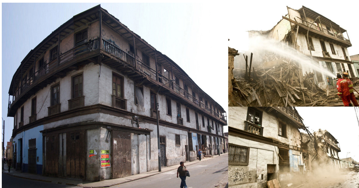
Figura 6. Edificio El Buque antes y después del colapso. En noviembre de 2012, un incendio causó el colapso de esta mansión histórica construida en 1753 y nominada Monumento Nacional en 1988 .
