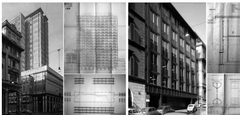
Figura 1. Architettura in acciaio e documentazione d'archivio alla scala del dettaglio costruttivo: a sinistra la sede direzionale della Rai a Torino e a destra il palazzo dell'Enpam a Roma (Archivio Rai, Archivio Centrale dello Stato).
